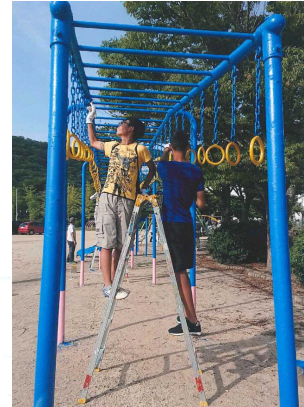
小学校の遊具の ペンキ塗り
